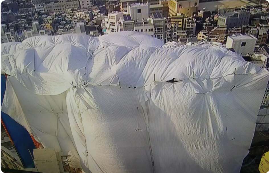
[사진1] 재해발생 현장 101동 옥탑보양 전경
