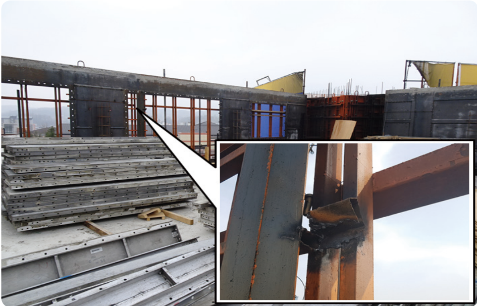
[사진 3] 작업장소 및 용단 대상 (6층 강품 수평부재)
