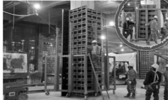
[변경] 화인폼 시공
