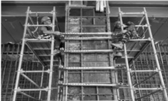
[기존] 재래식 유로폼 시공
