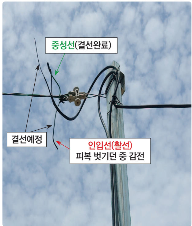
[사진2] 재해자가 작업중이던 장소 및 인입선 모습
