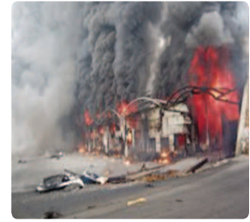
이천 물류 냉동창고 신축공사 화재 ('08. 1. 7 사망40, 부상10)
