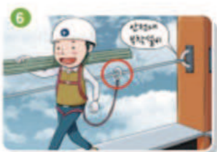
6 추락방호망 설치가 곤란한 경우 근로자에게 안전대 착용 및 사용
