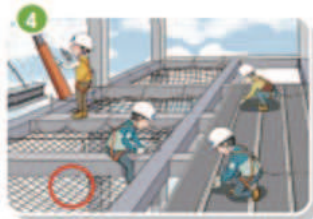
4 철골작업 시 근로자 주요 이동통로에 추락방호망, 안전대 부착설비 설치
