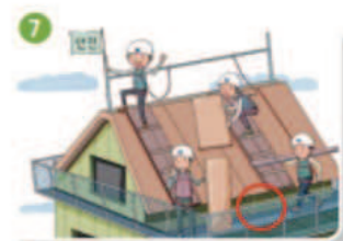
7 선라이트 등 강도가 약한 지붕 위에서 작업 시 발판 또는 추락방호망 설치
