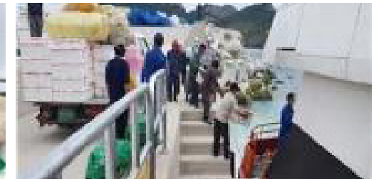
만재항 접안시설 개선 후
